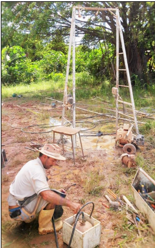
Figura 5: Perfuração do poço de bombeamento.
