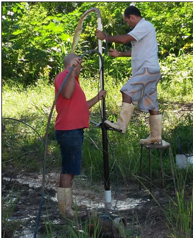
Figura 6: Cravação da haste de perfuração.
